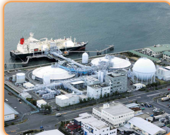
▲廿日市工場のように タンカーから工場のタンクへ液化天然ガスを移しています。
