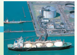
Mizushima LNG terminal (Mizushima LNG Co., Ltd.)
