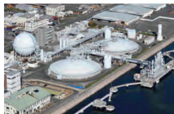
Hatsukaichi LNG terminal
