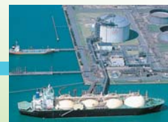
Mizushima LNG terminal (Mizushima LNG Co., Ltd.)
