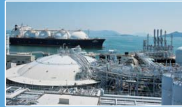
Hatsukaichi LNG terminal
