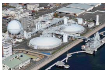
Hatsukaichi LNG terminal
