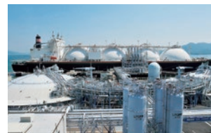
LNG ship entering port for loading or unloading and our Hatsukaichi LNG terminal
