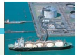
Mizushima LNG terminal (Mizushima LNG Co., Ltd.)
