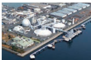
Hatsukaichi LNG terminal
