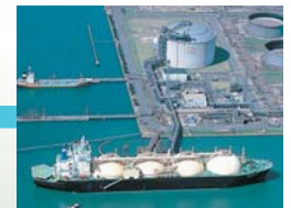
Mizushima LNG terminal (Mizushima LNG Co., Ltd.)
