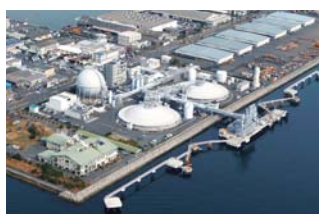
Hatsukaichi LNG terminal
