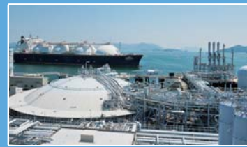
Hatsukaichi LNG terminal
