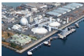
Hatsukaichi LNG terminal
