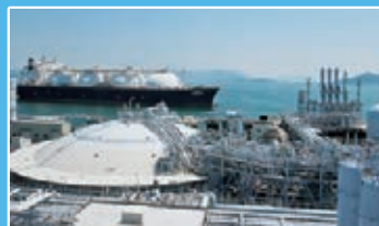
Hatsukaichi LNG terminal
