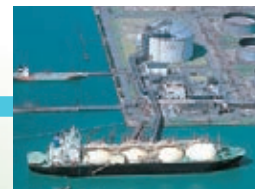
Mizushima LNG terminal (Mizushima LNG Co., Ltd.)
