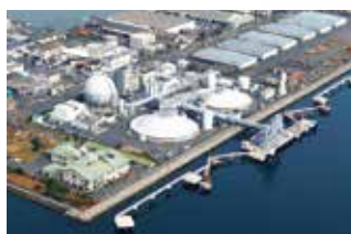
Hatsukaichi LNG terminal
