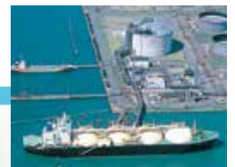
Mizushima LNG terminal (Mizushima LNG Co., Ltd.)
