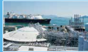
Hatsukaichi LNG terminal
