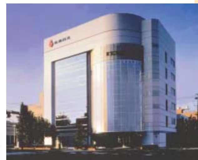
ガストピアセンター
