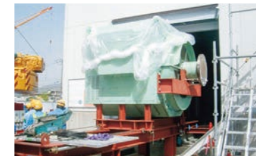
コージェネレーション改造工事
