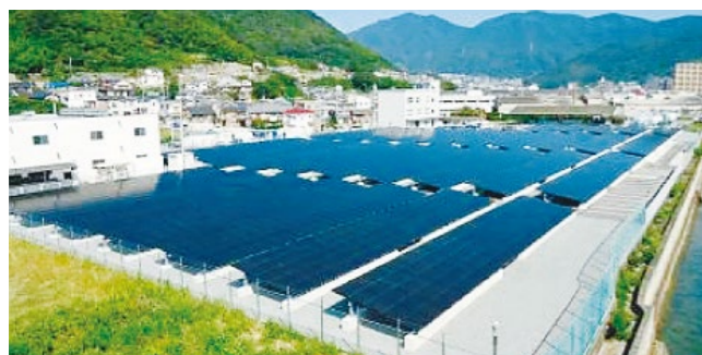
阿賀太陽光発電所
