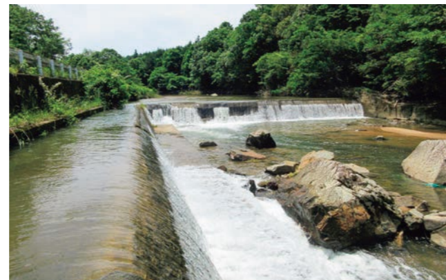
取水堰および導水路
