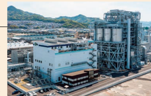
海田発電所(バイオマス発電)
