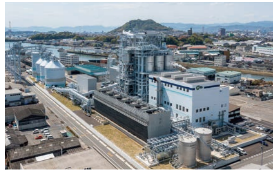
海田発電所(海田バイオマスパワー)
