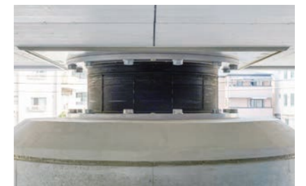
免震装置(柱頭免震構造)
