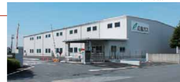
広島ガス資材センター
