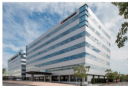
▲ CN都市ガスの契約締結先である三菱重工コンプレッサ株式会社
