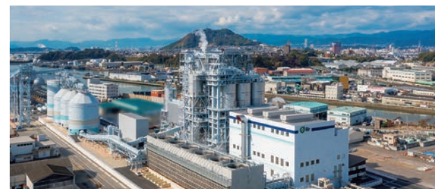
2021年4月に操業を開始した海田発電所
