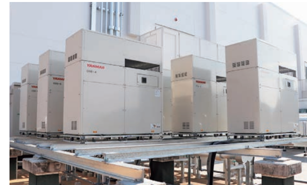
停電対応型ガスコージェネレーションシステムの導入事例
