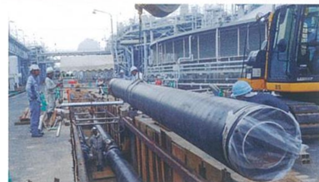
温水二重管設置工事
