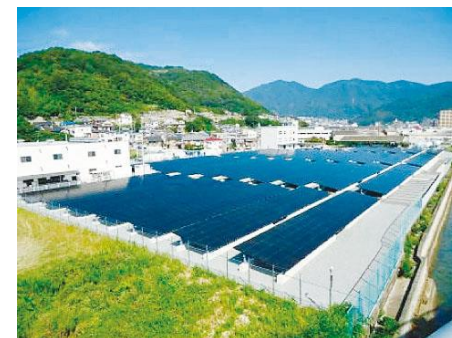
阿賀太陽光発電所(呉市)
