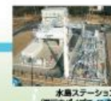
水島ステーション (瀬戸内パイプライン㈱)
