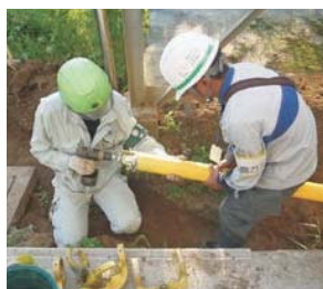
導管修繕作業
