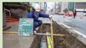
東広島市中心部ガス管理設工事
