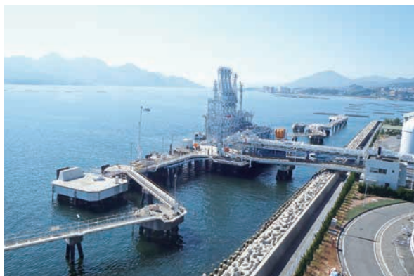
廿日市工場の栈橋機能拡大工事(平成27年12月完成予定)
