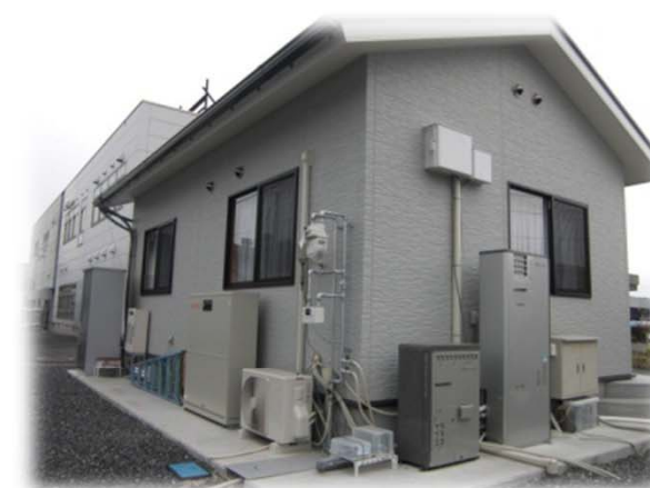
スマートエネルギーハウス 実験棟
