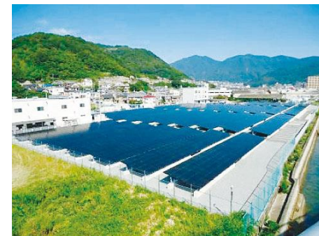
阿賀太陽光発電所(呉市)
