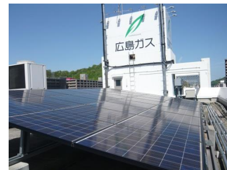
太陽光発電(尾道支店屋上)
