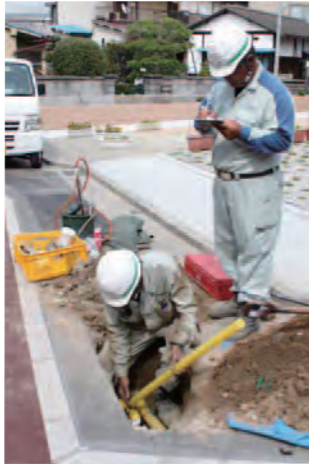
経年ガス導管入替え作業
