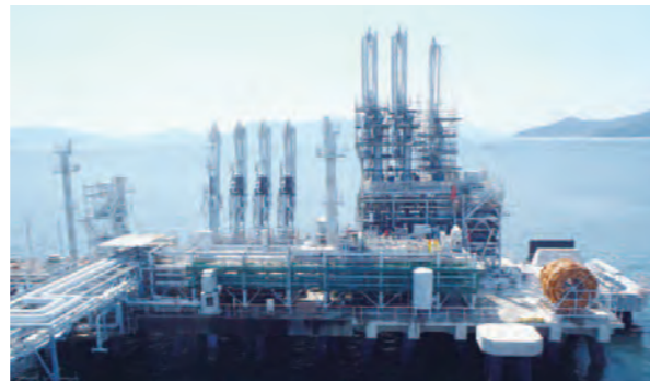
廿日市工場の栈橋機能拡大工事
