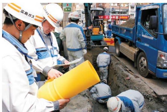
経年ガス導管入れ替え作業
