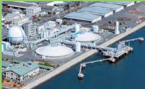
都市ガスの安定供給と将来の需要拡大に向けて、廿日市工場の栈橋機能拡大工事実施を決定しました。本工事により現行の小型LNG船と併用して、標準LNG船の受入体制を整えていきます。
