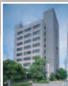
皆実町本社ビルの竣工 [1982年(昭和57)10月]
