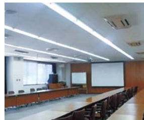
LED照明(会議室)
