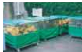
PE管の残管置場
