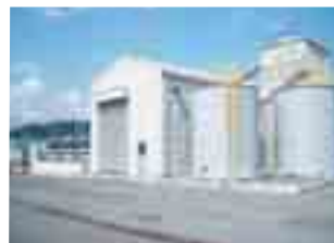
水処理設備(旧海田工場跡地)
