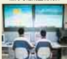
中央監視制御室(本社)
