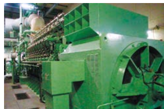
ガスコージェネレーションシステム(廿日市工場)
