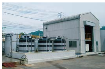
水処理装置(海田基地)
