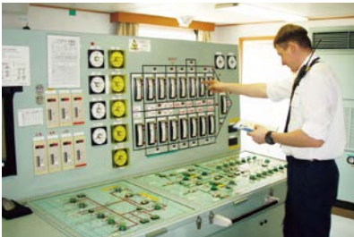
パラスト水確認作業 LNG(液化天然ガス)輸送時に外来生物リスクを低減するため、パラスト水を管理しています。
