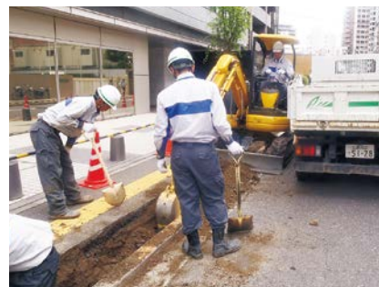
ガス管工事
