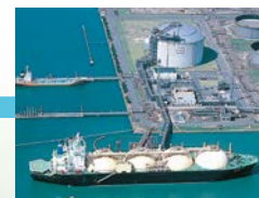
水島LNG基地 (水島エルエヌジー(株))
