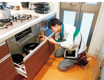
ガス設備安全点検
