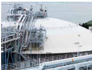
貯槽タンクは地下に構築した外壁の厚さが2m以上のコンクリートピット内に据え付けられ、内部のLNG液面は地表よりも低く、万一の場合でも漏れ出すことはありません。
