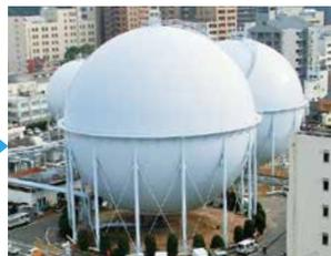
基礎部分は地中深くの支持地盤まで杭が打ち込まれています。その基礎の上に支柱と球体を設置し、大規模地震にも耐えられるよう設計・施工しています。
