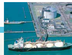
水島LNG基地 (水島エルエヌジー(株))
