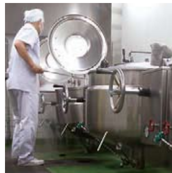
▲蒸気回転釜 壁掛けにより機器下を十分に取り掃除がしやすくなっています。
