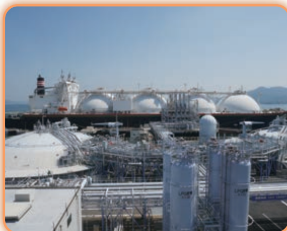
▲廿日市工場のように タンカーから工場のタンクへ液化天然ガスを移しています。
